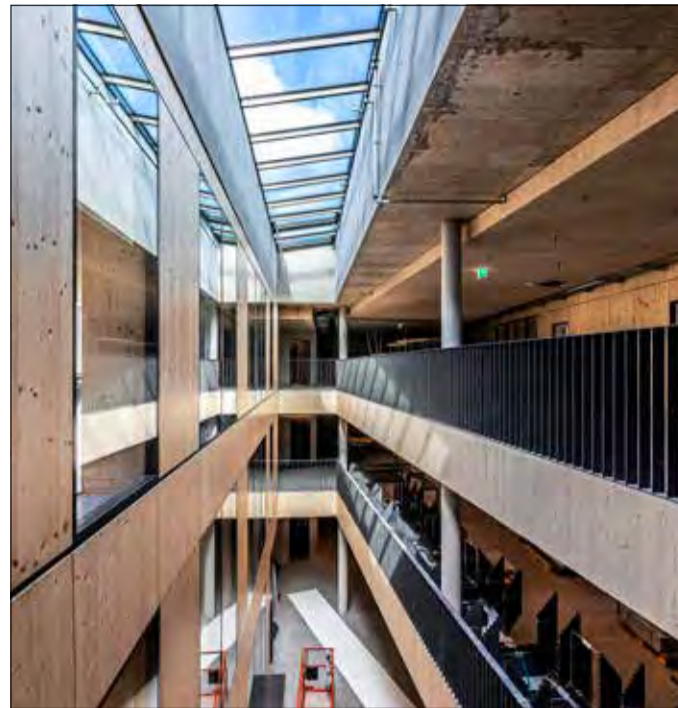
Klare Linien und viel Licht: Der Schulalltag im ersten Teil des „Staudi“-Neubaus hat begonnen. (Fotos: M. Spiegelhalter)
