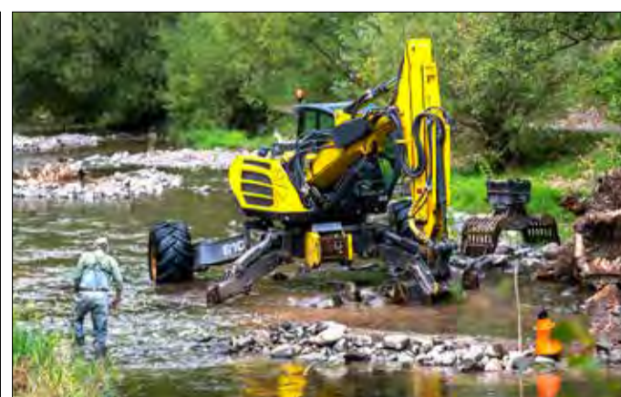
Schweres Gerät ist aktuell an der Dreisam im Einsatz.
