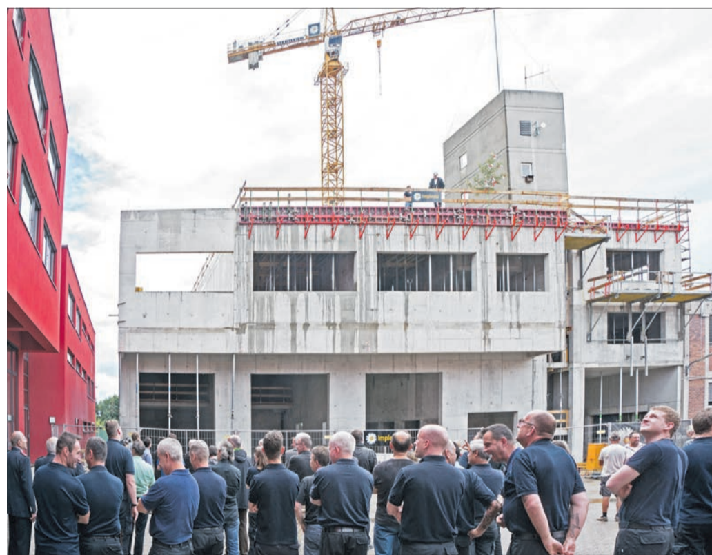
Richtfest: Der Bau des Technikzentrums nimmt deutliche Konturen an. (Foto: A. J. Schmidt)
