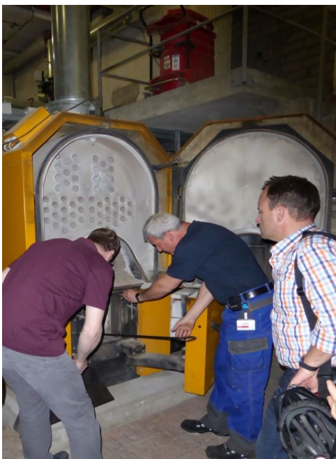
Abb. 19 u. 20: Begutachtung Holzackschnitzel-Kessel und Schubboden Silo, Weiherhof-Schulen
