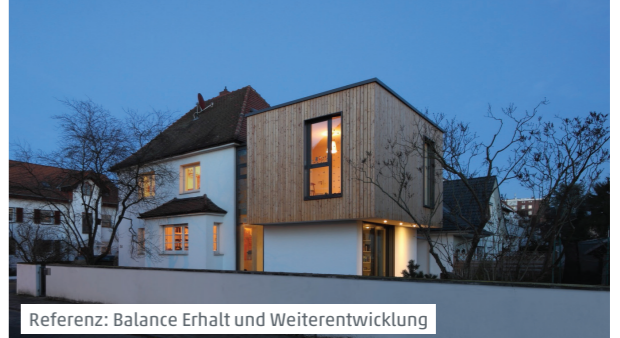
Mooswald-West: Beispiel einer vorhandener Verdichtung
