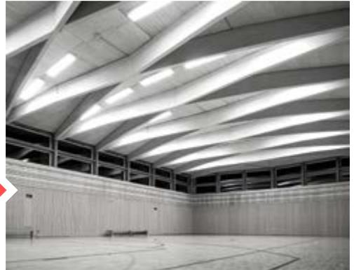
Die Holzskelettbauweise mit Stützen und X-Trägern im Dach bildeten das Gerüst. Die anderen Bauteile wie Außenwände, Innenwände, Fußbodenaufbau, Akustikmaßnahmen und Dachdämmung konnten in großem Maße in Eigenleistung gebaut werden.
