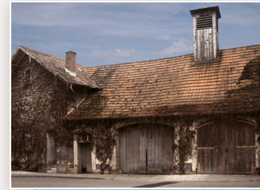
Abb.27 Farrenstall vor dem Umbau Waltershofen
