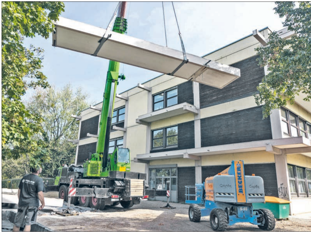
Balkone adieu: Seit Ende Juli laufen bereits die Arbeiten an der Außenfassade der Anne-Frank-Schule in Betzenhausen. Im ersten Bauabschnitt sind die Bauarbeiter damit beschäftigt, die „Balkone“, also jene Betonfertigteile, die in den 70er-Jahren bei Schulbauten modern waren, abzutragen. Mit einem Autokran werden die Platten und ihre Träger abmontiert und anschließend zerkleinert. (Foto: A. J. Schmidt)
