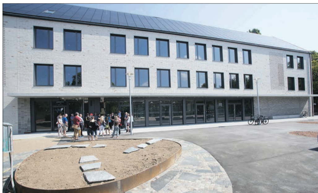
Schulgebäude mit Vorbildfunktion: Im Neubau der Pestalozzi-Schule sind acht neue Klassenräume und ein großer Mensabereich entstanden. Durch Photovoltaik- und Lüftungsanlage bietet das Passivhaus das ganze Jahr über angenehme Temperaturen. (Foto: A. J. Schmidt)
