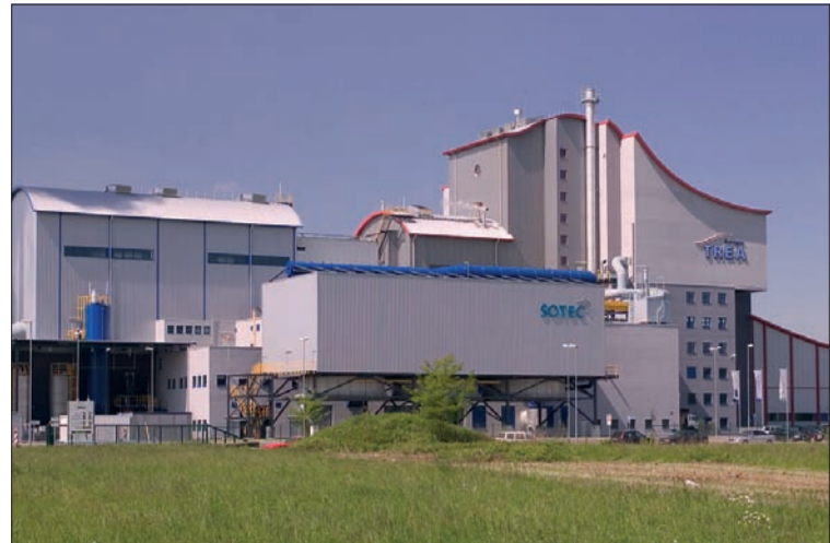
In der Verbrennungsanlage TREA in Bremgarten wird seit 2005 der Freiburger Restmüll verwertet. (Foto: TREA)
