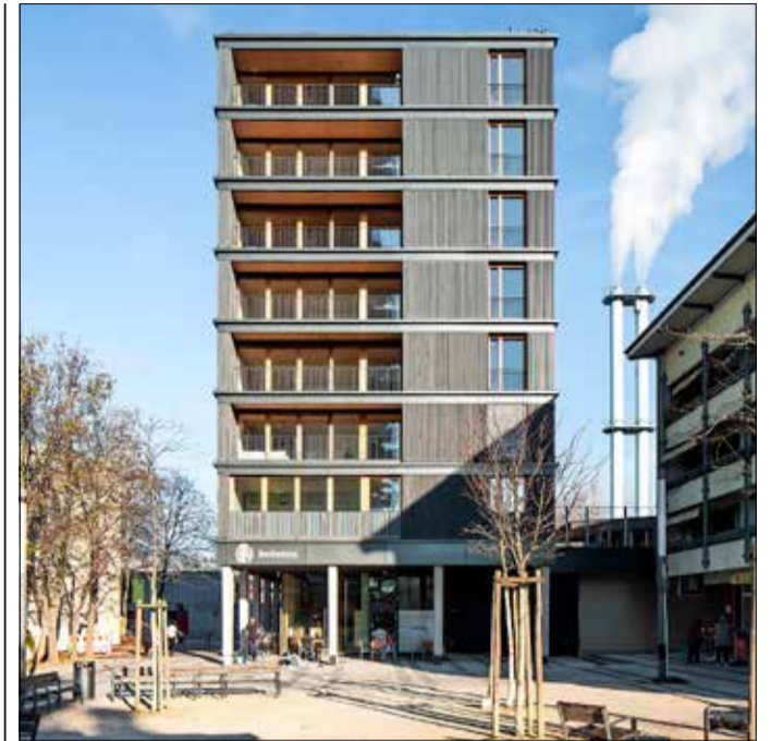
Leuchtturm: Auch wenn es von außen nicht zu sehen ist – die „Buggi 52“ ist in den Obergeschossen vollständig aus Holz gebaut. In Freiburg ist es das erste Hochhaus dieser Bauart und hoffentlich ein Vorbild für weitere Projekte. (Foto: Baurechtsamt)
