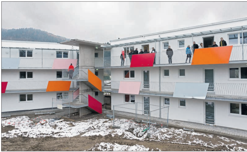
Mit Farbtupfer: Als Ersatz für die maroden Baracken hat die Stadtbau in der Hammerschmiedstraße einen Neubau erstellt. (Foto: A. J. Schmidt)
