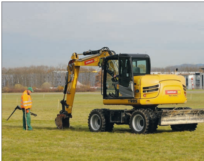
Gaaaanz vorsichtig: Bei der Räumung von „Verdachtsstellen“ ist Fingerspitzengefühl gefragt – erstens, um den Magerrasen nicht zu zerstören, und zweitens, weil es sich ja bei jedem Metallteil auch um eine Bombe handeln könnte. (Foto: E. Heusel)
