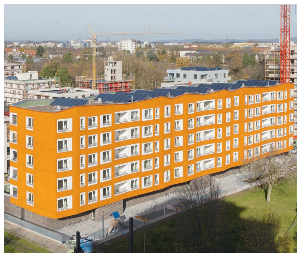
Gefaltet, nicht gestaucht: Hinter der ansprechenden Gebäudearchitektur verbirgt sich Platz für 40 geförderte Mietwohnungen. Auf dem Bild ist gut zu sehen, dass die Bebauung der Gutleutmatten mächtig voranschreitet. (Foto: A. J. Schmidt)
