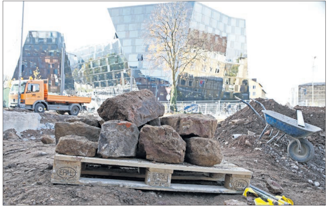
Steinerne Zeugen: Am Platz der Alten Synagoge tauchen unerwartet Fundamentreste der 1938 zerstörten Synagoge auf. Der Gemeinderat beschließt, bei den bisherigen Planungen zu bleiben.
