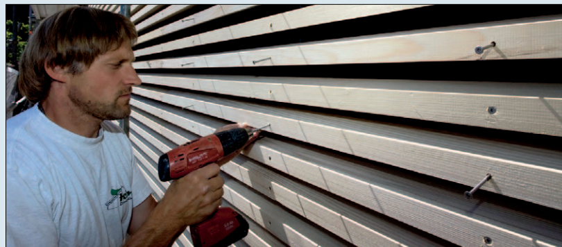
Holzbau in Rekordzeit: Nur sieben Monate vergingen zwischen Grundsteinlegung und Eröffnung (Foto: K. Echle)
