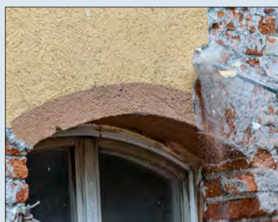
Detailarbeit: Ringsum werden Drainagegräben angelegt, die das Mauerwerk vor Feuchtigkeit schützen (oben links). Historische Bauelemente wie dieses Toilettenoberlicht werden bewahrt (Mitte links). Der alte Putz kommt runter und wird später durch einen speziellen Dämmputz ersetzt (unten links). Das historische Aussehen mit Sprossenfenstern bleibt erhalten (rechts).
