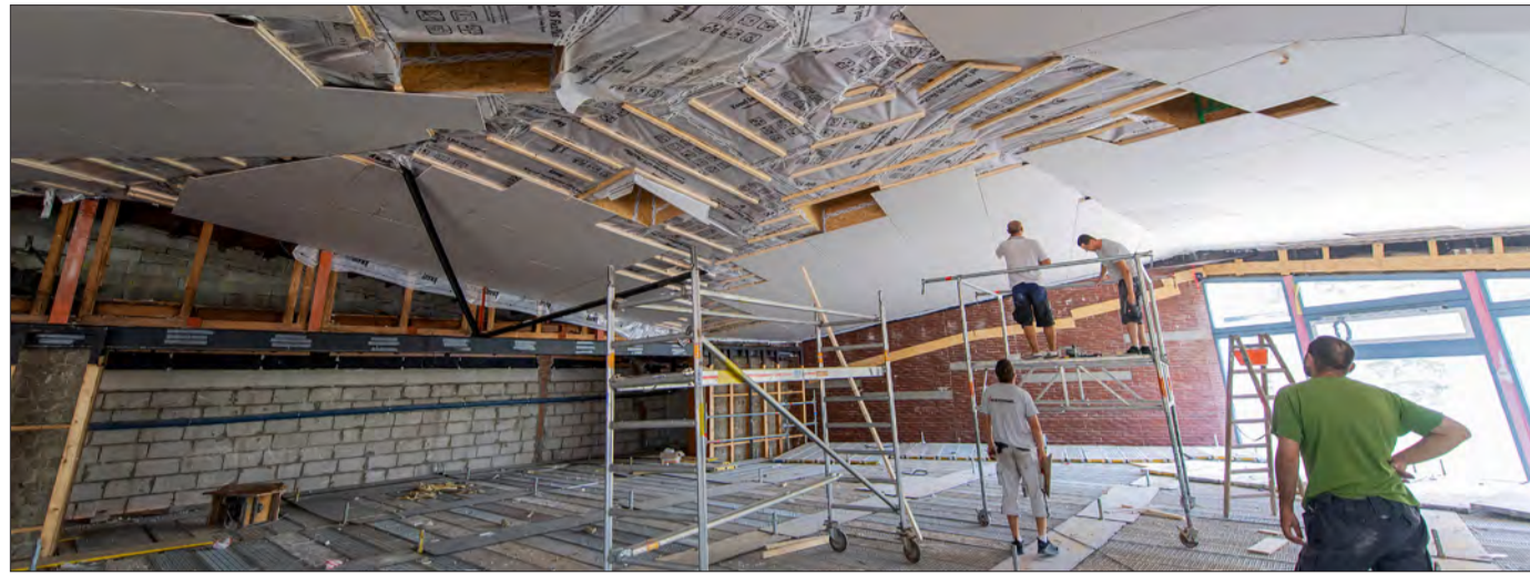
Deckenpuzzle: Im Haus der Jugend wird derzeit die Decke im Großen Saal komplett erneuert. Das wird man nach der Sanierung aber kaum sehen, da die spektakuläre originale Akustikdecke wieder eingebaut wird. (Foto: P. Seegeer)
