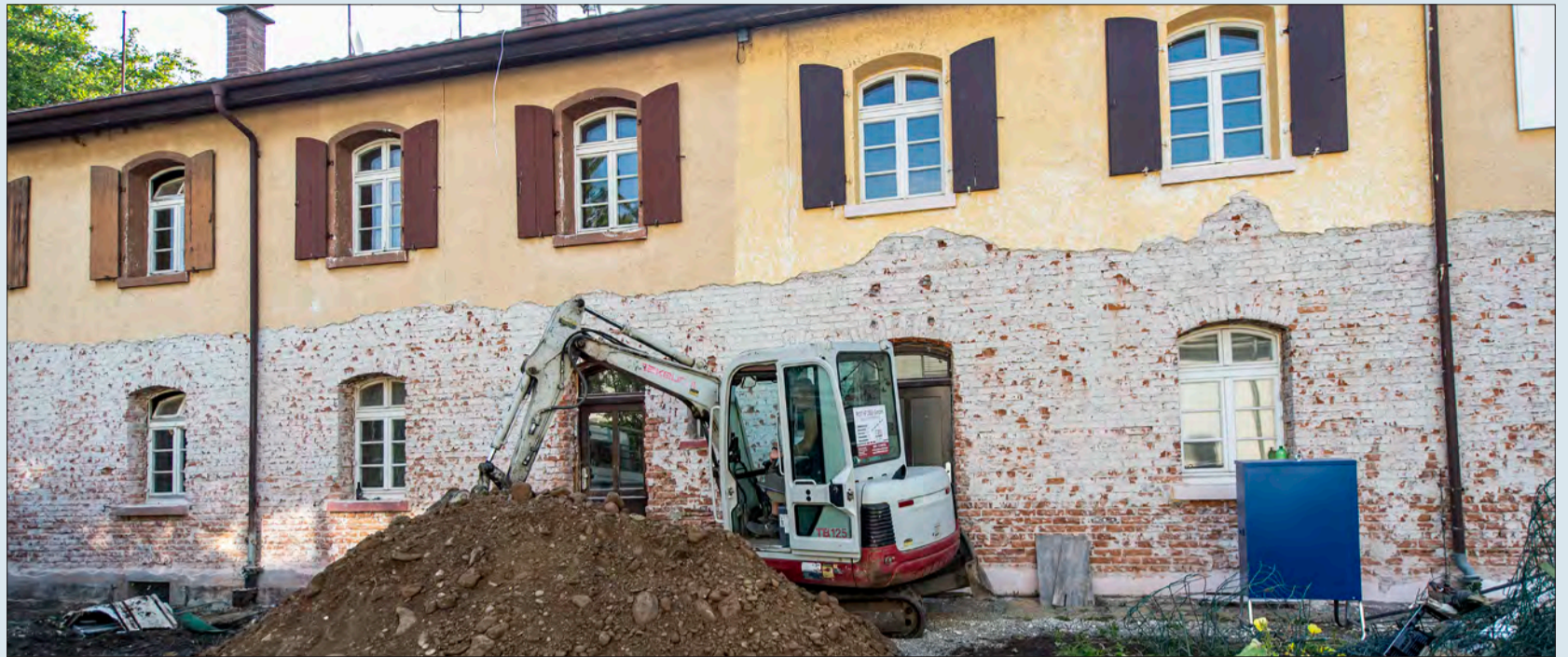
Bagger marsch: Nicht mit der Abrissbirne, sondern eher mit der feinen Klinge gehen die Bauarbeiter bei den Knopfhäusle vor. Die historische Substanz soll so weit wie möglich erhalten bleiben. Lediglich in den Vorgärten bleibt kein Stein auf dem anderen – sie werden später neu angelegt. (alle Fotos: P. Seeger)
