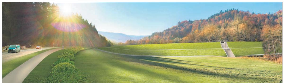
Die Visualisierung zeigt das Bohrerthal hinter Günterstal mit dem 275 Meter langen Damm des Rückhaltebeckens. Neben der L 124 ist auch der im Bau befindliche Radweg erkennbar.
