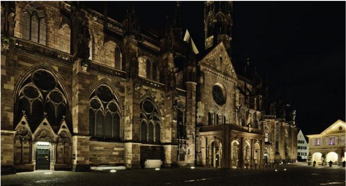
Bild: Anstrahlung mit der neuen LED-Beleuchtung in warmweißer Lichtfarbe.
