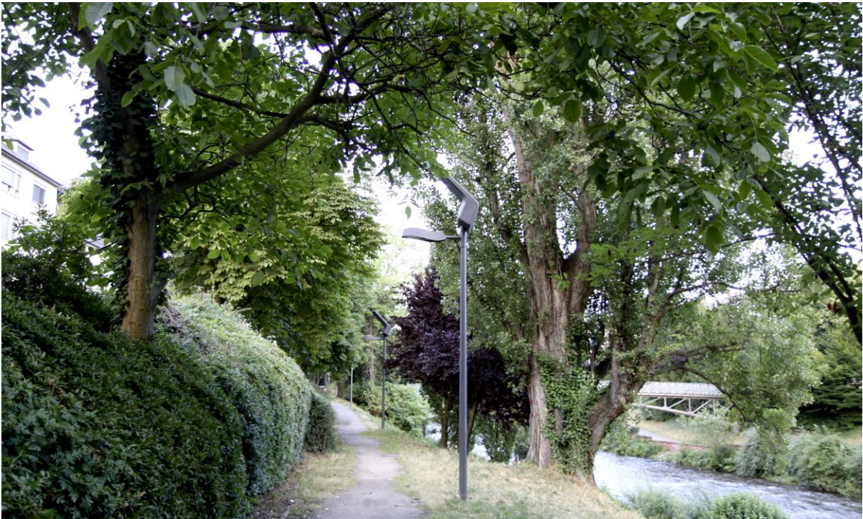
Bild: Mit den netzautarken Außenbeleuchtung können Wege ausgeleuchtet werden, die bisher nicht erschlossen wurden.
