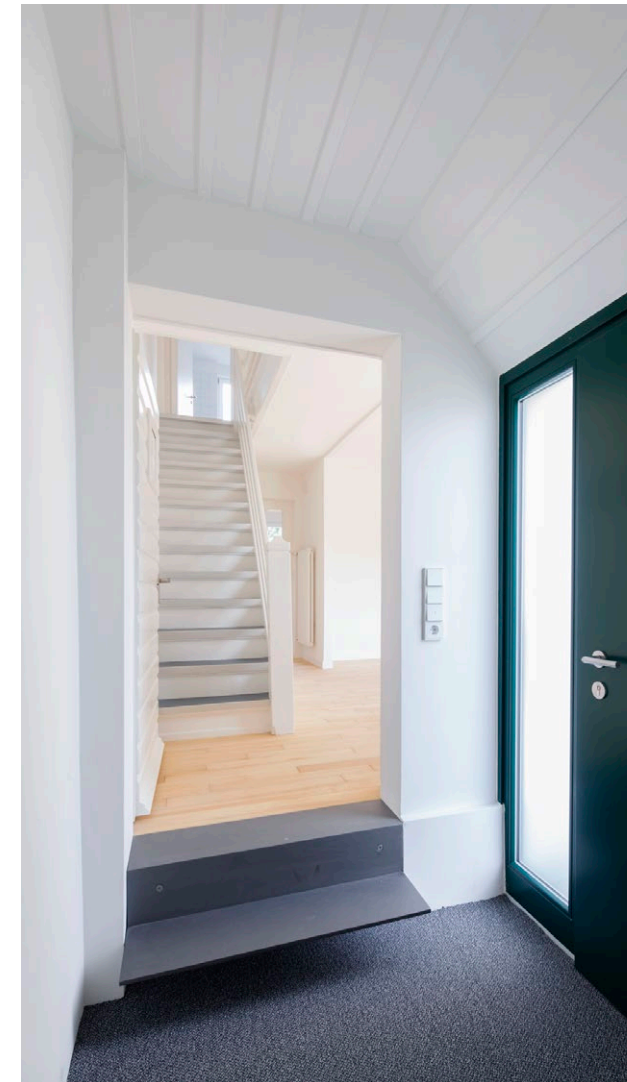
Windfang mit neuer Treppenstufe aus Stahl
