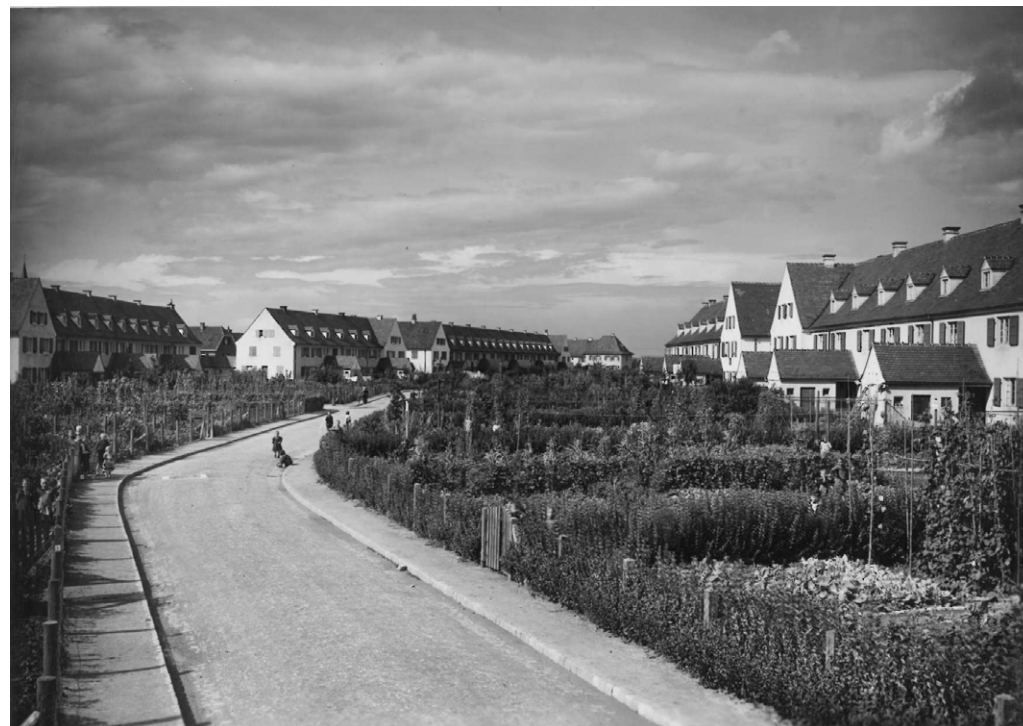
Historische Aufnahme Gärten Bauhöferstraße
