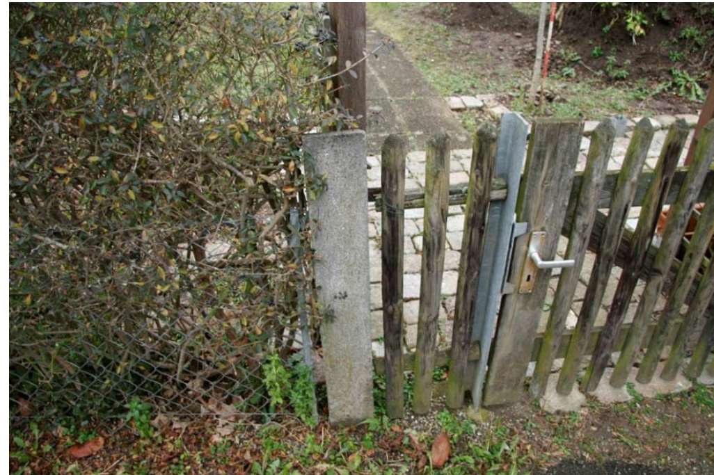
Typisches Bild: Maschendrahtzaun, Ligusterhecke, Beton- pfosten und Tor aus Holzlatten
