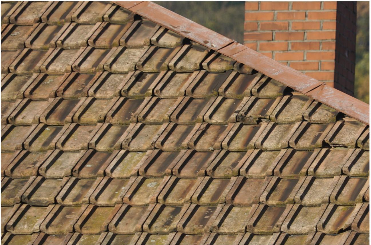
Falzziegeldeckung mit Überdeckung des Dachgrats aus Blech
